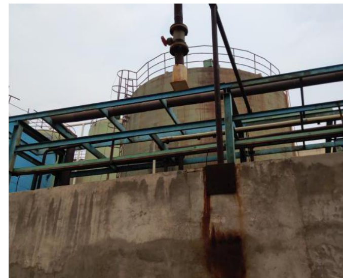
东方锆业酸碱储罐区
