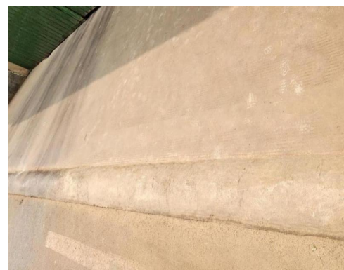
防流失阻隔设施
